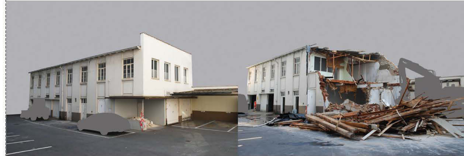
Eine Abriss-Baustelle im Fokus des Stadtlaboratoriums: Nichts geht wirklich verloren.
